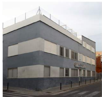
ANTES de la intervención
